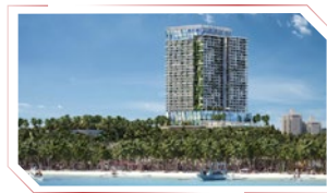
Dự án Movenpick Hạ Long
