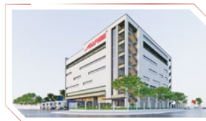
Tòa nhà Công nghiệp Searee (Searee Industrial Building - SIB)
