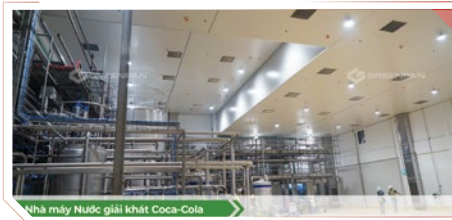
Panel Greenpan tại nhà máy Coca Cola
