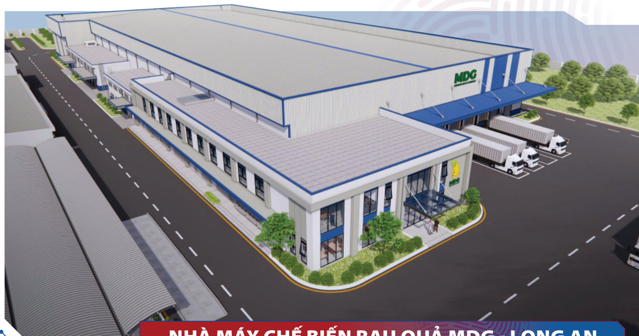
NHÀ MÁY CHẾ BIẾN RAU QUẢ MDC - LONG AN
